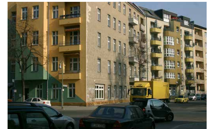
Mietshäuser in der Böhmisches Straße.
